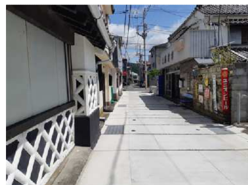
道路修景舗装 (前・後)
